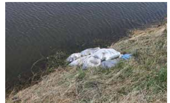
Deichläufer haben eine Sasse mit Sandsäcken gesichert
